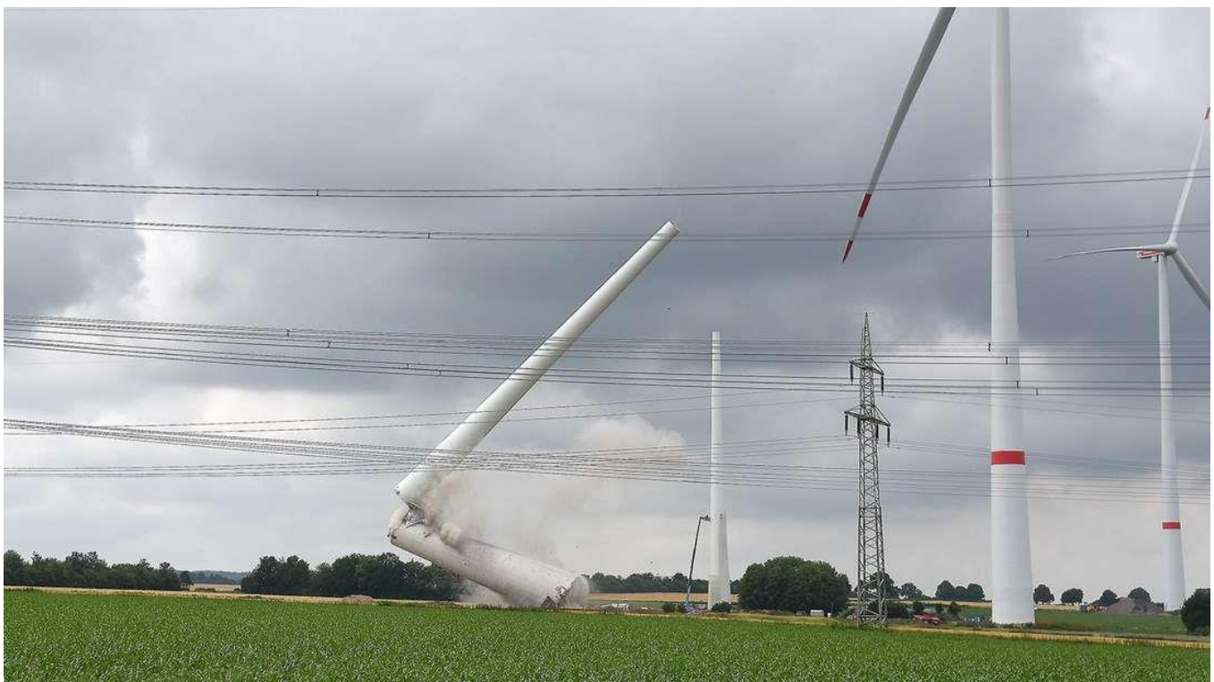
Rückbau durch Sprengung
